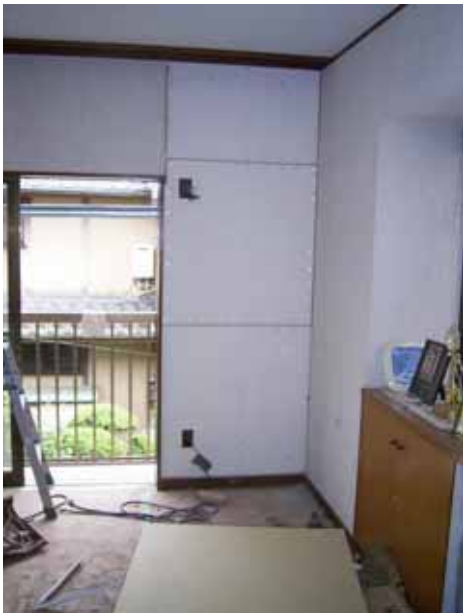
『かべ大将』施工後
