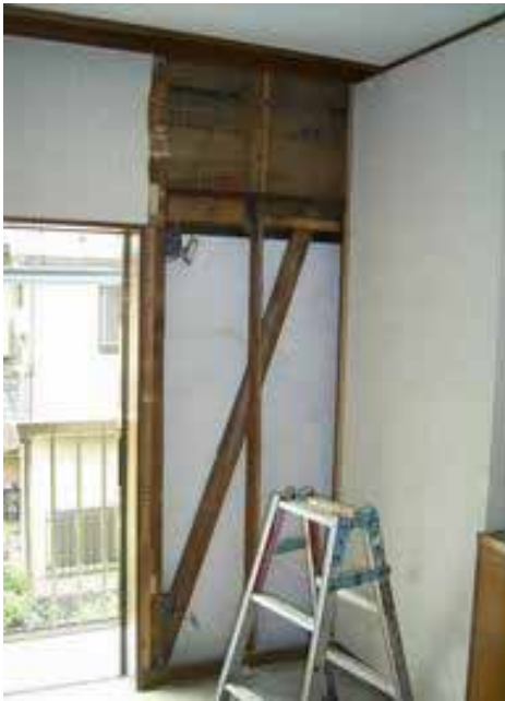
『かべ大将』施工前
