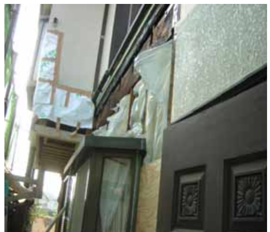
ベランダは撤去し、周りの壁、木部等を補修しました。
