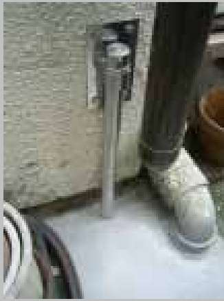
耐震補強金物 GDアンカー 7.5万円/ヶ所
